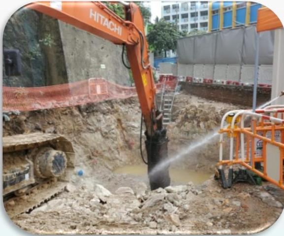
本工程主要採用鑽孔裂石法
