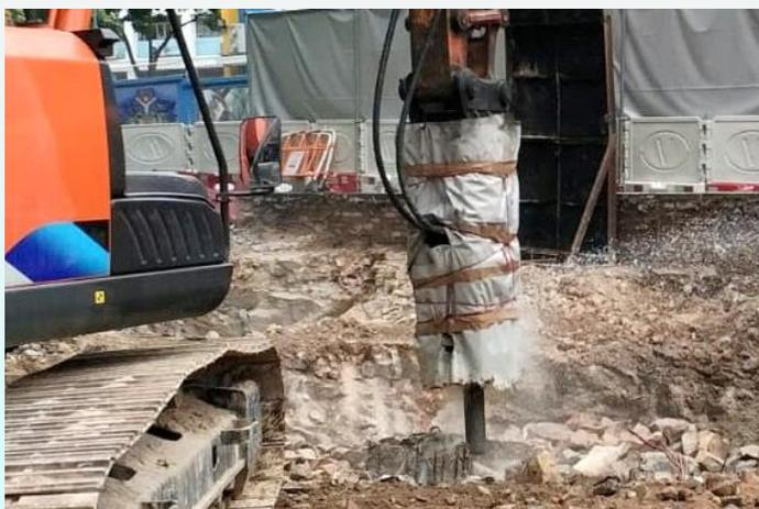
使用隔音布料覆蓋機械設備
